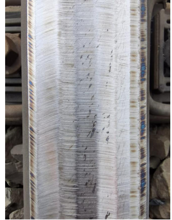
Промежуточный результат устранения контактно-усталостных трещин шлифовкой
